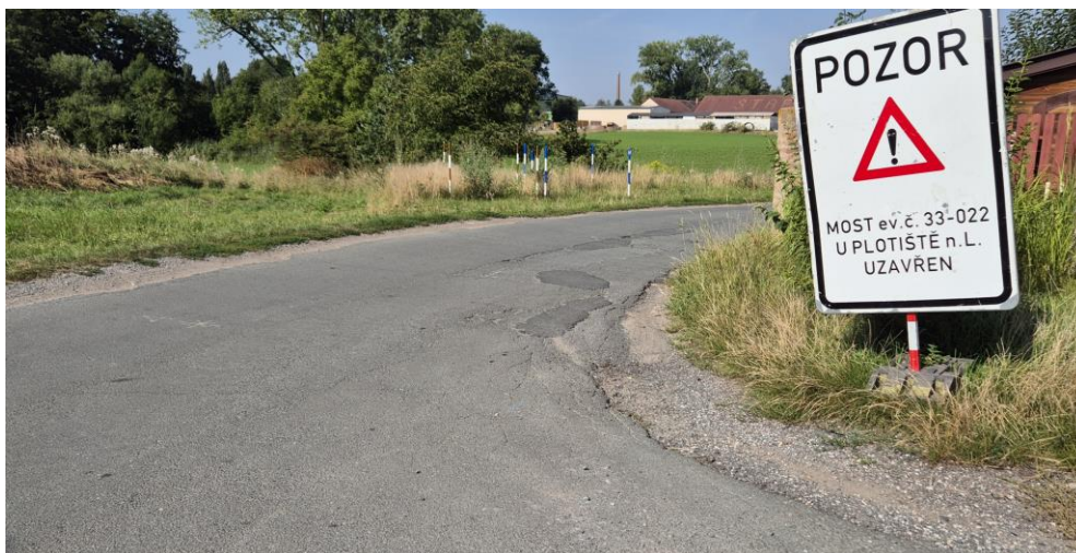
Obrázek 7 Nedostatečný rozhled ze sjezdu z důvodu oplocení pozemku
