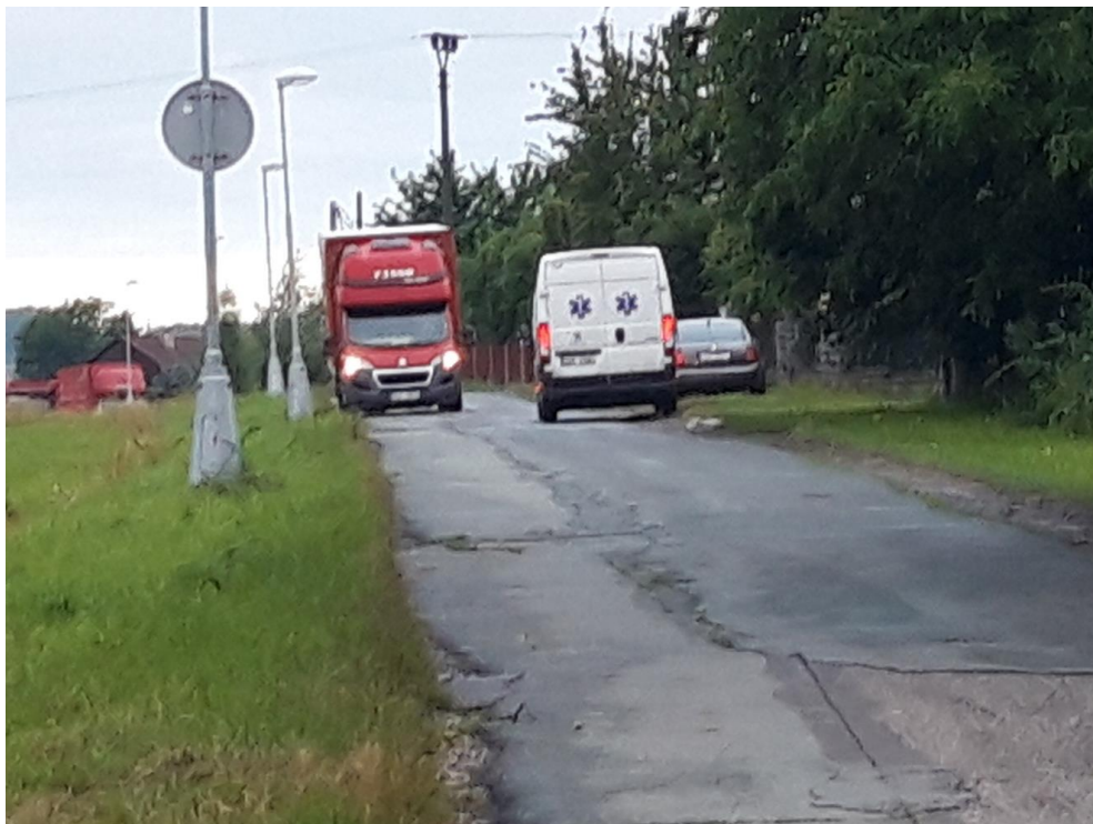
Obrázek 11 Vzhledem k nedostatečné šířce vozovky musí protijedoucí vozidla při vzájemném míjení vyjet mimo komunikaci.
