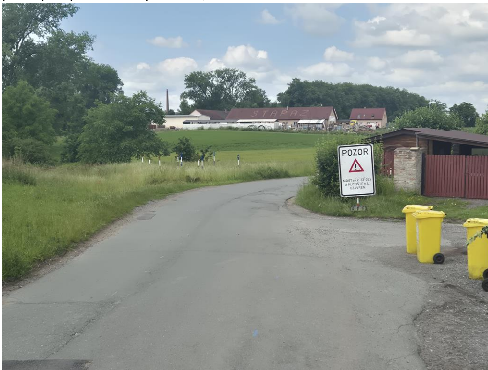
Obrázek 6 Nedostatečný rozhled pro zastavení z důvodu oplocení pozemku
